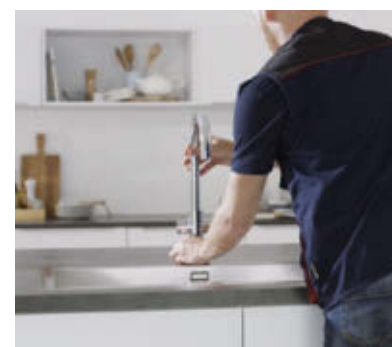
Připevněte baterii pomocí montážní sady k dřezu nebo kuchyňské lince.
