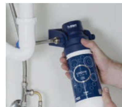
Upevněte držák filtru do linky a našroubujte filtr do hlavice. Poté připojte filtr k přípojce studené vody.
