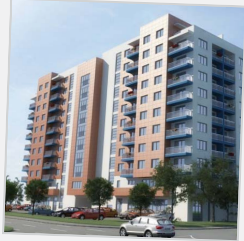
Bytový dom Ružinovská 44, Bratislava Referencie ViVa
