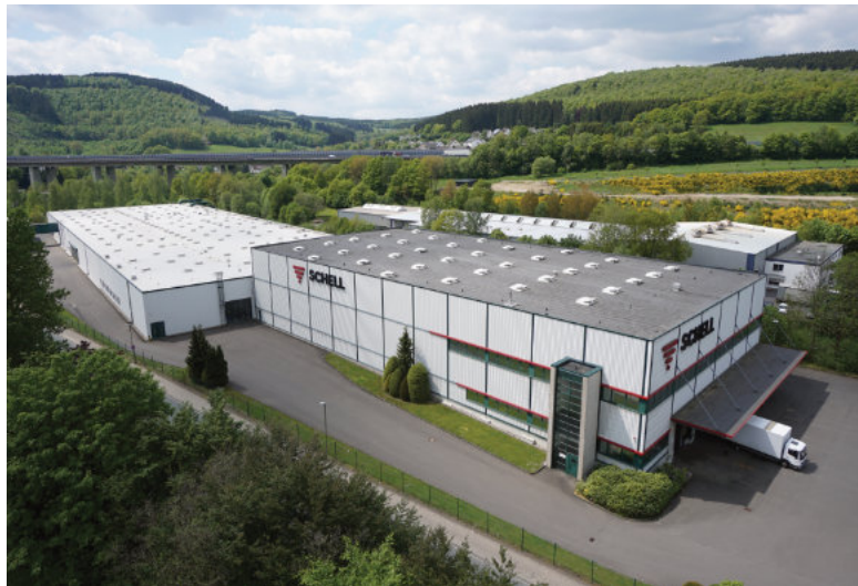
Závod 2 Výrobná hala s logistickým centrom
