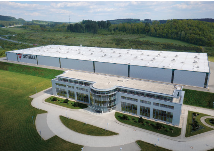
Závod 1 Výrobná hala, administratívna budova a školiace centrum
